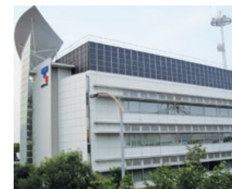
お客様の環境・エネルギー事業をトータルサポート（太陽光発電システム施工例）
